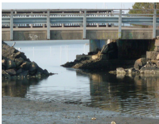
Bildet viser Husøybrua ved moderat lavvann. Fyllingen mellom broene kommer lengre ut enn brokarene! Bredden på sundet som opprinnelig var ca 100 m er derved blitt redusert til under 5 m!
